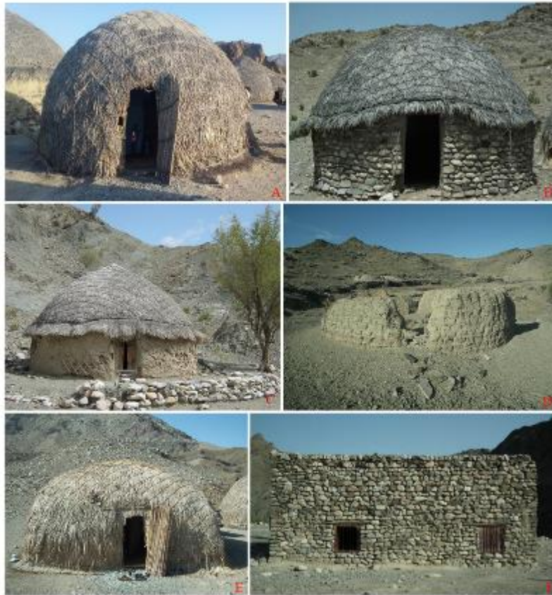
تصویر ۳. A) سازه مدور دازی، B) سازه مدور سنگی، C) سازه مدور حصیری گلی، D) بقایای سازه مدور خشتی، E) سازه‌ای با پلان بیضی، F) سازه‌ای با پلان راست‌گوشه (نگارندگان، ۱۳۹۸).
