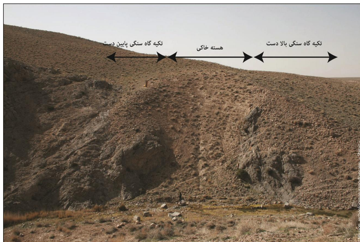
شکل ۷: دید از غرب بقایای سد دیدگان که در یکی از دو شیب پشتیبان این بنا حفظ شده است. نمای مقطعی از ساختار سه جانبه این سد گرانشی را نشان می‌دهد (عکس از Tijds De Schacht).
