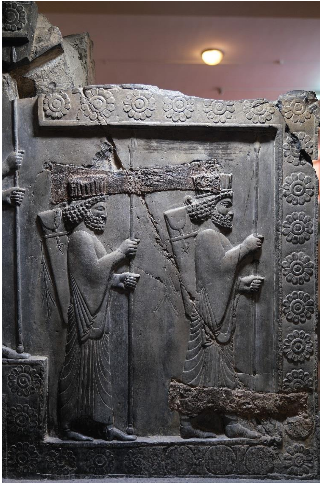
شکل ۱۱. ایجاد نقش برجسته روی بست دم - چلچله‌ای. پلکان جنوبی کاخ مرکزی، تخت جمشید (عکس از ه. کریم مسیحی).
