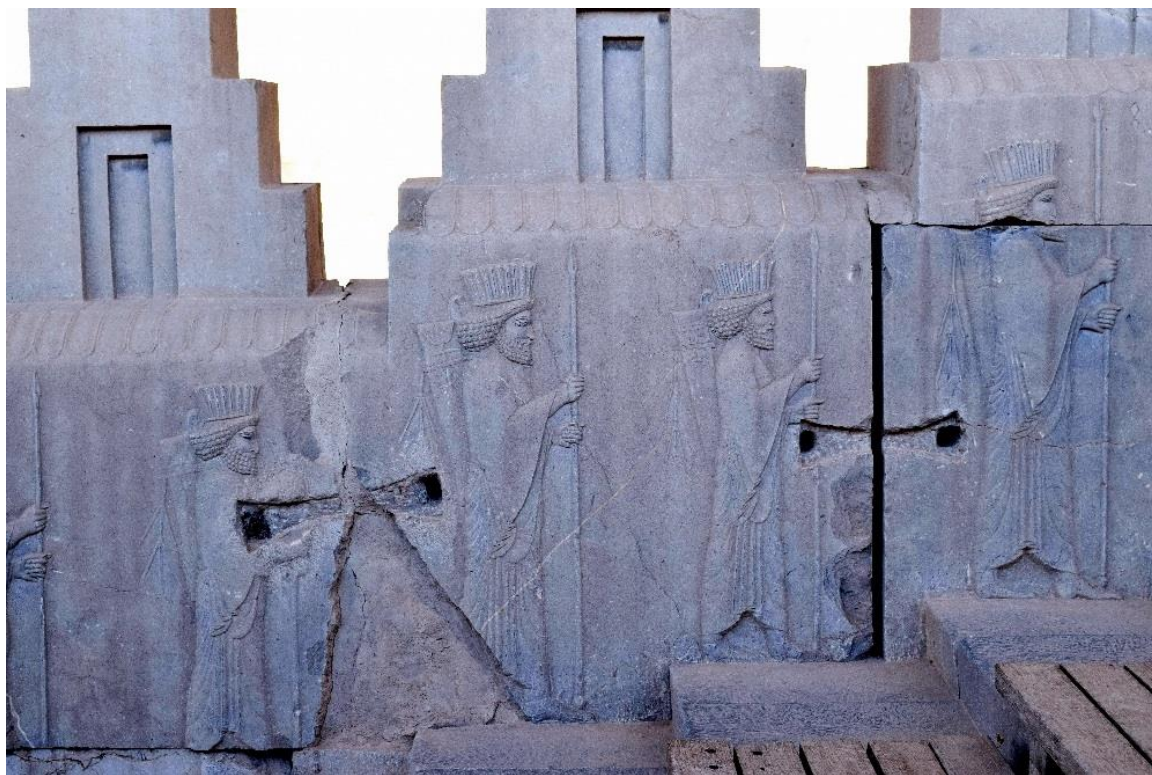
شکل ۹. بست‌های دم - چلچله‌ای روی نقش برجسته نگهبانان پارسی. پلکان شرقی تالار ستوندار بزرگ، تخت جمشید (عکس از ز. زهبری).
